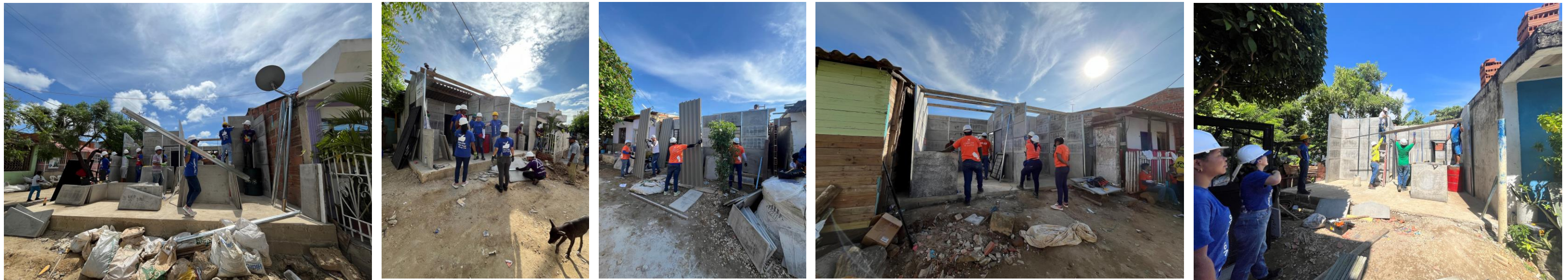
CONSTRUCCIÓN DE UNIDADES HABITACIONALES
